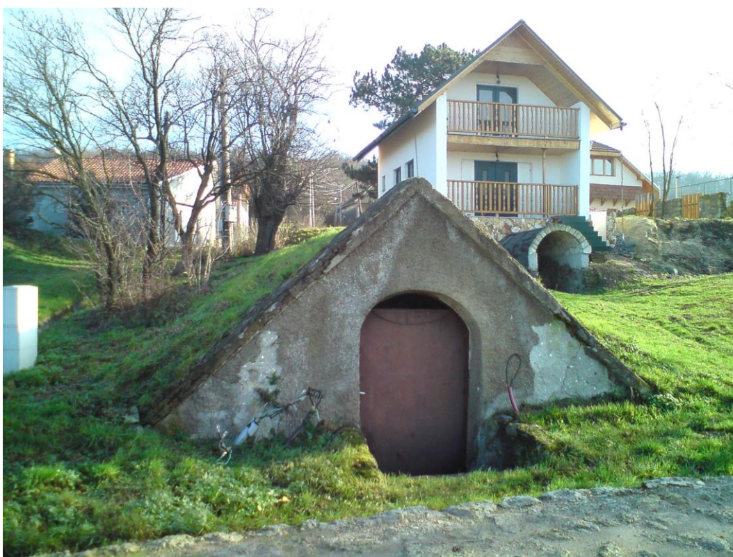
OBR. 50 PORTÁL PIVNICE Č. 10, TRADIČNÝ TYP S NEVHODNOU POVRCHOVOU ÚPRAVOU A VRÁTAMI, V POZADÍ VPRAVO CHATKA NA PARC. Č. 146/3 S NOVODOBÝM VSTUPOM DO PIVNICE Č 21
