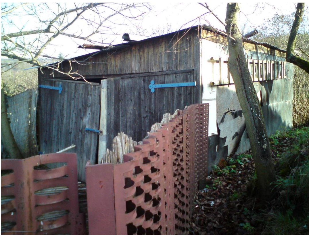
OBR. 46 PIVNICA Č. 14 ZA DREVENOU BÚDOU V ZÁHRADĚ RODINNÉHO DOMU
