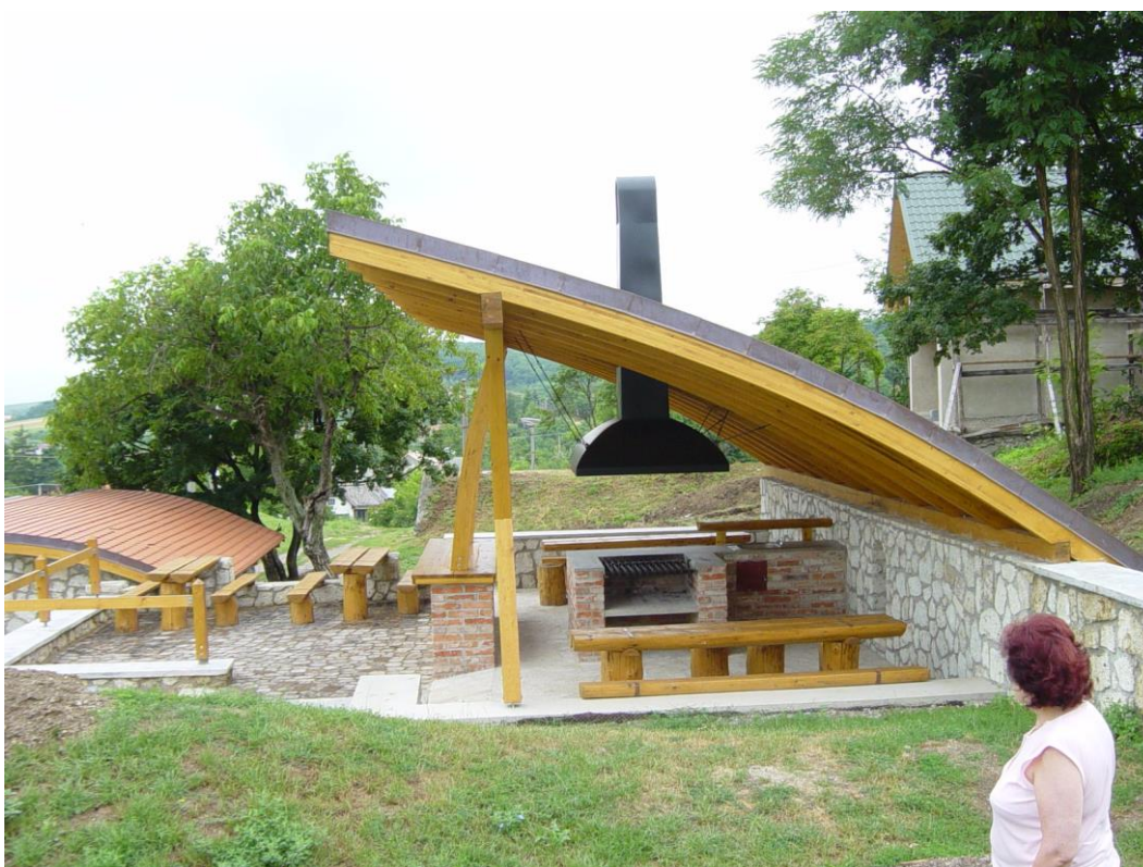
OBR. 26 POHĽAD Z JUHU NA OTVORENÝ PRÍSTREŠOK NAD PIVNICOU Č. 9 (GRÓFA SÁNDORA SZECHÉNYHO)
