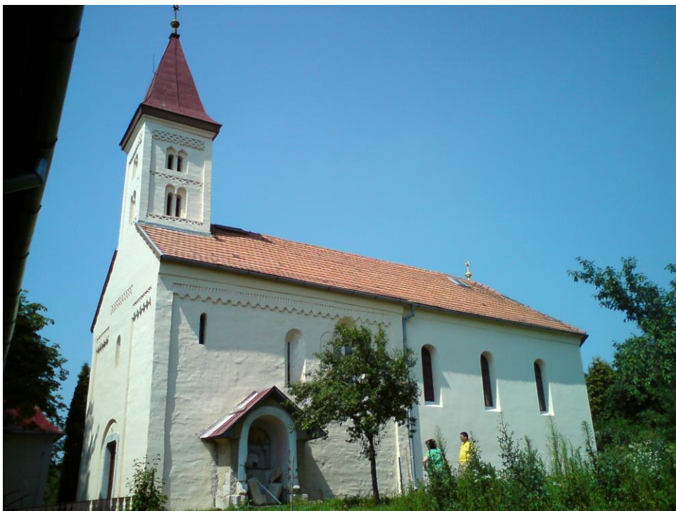
OBR. 3 NAJVÝZNAMNEJŠIA DOMINANTA OBCE – ROMÁNSKY KOSTOL Z KONCA 12. STOR., STAV PO KOMPLEXNEJ OBNOVE (NÁRODNÁ KULTÚRNA PAMIATKA)
