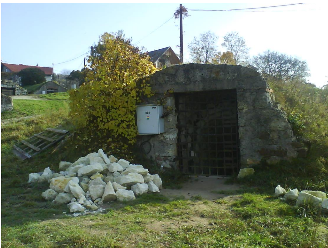
OBR. 54 PORTÁL PIVNICE Č. 6, STAV PRED OBNOVOU V R. 2008
