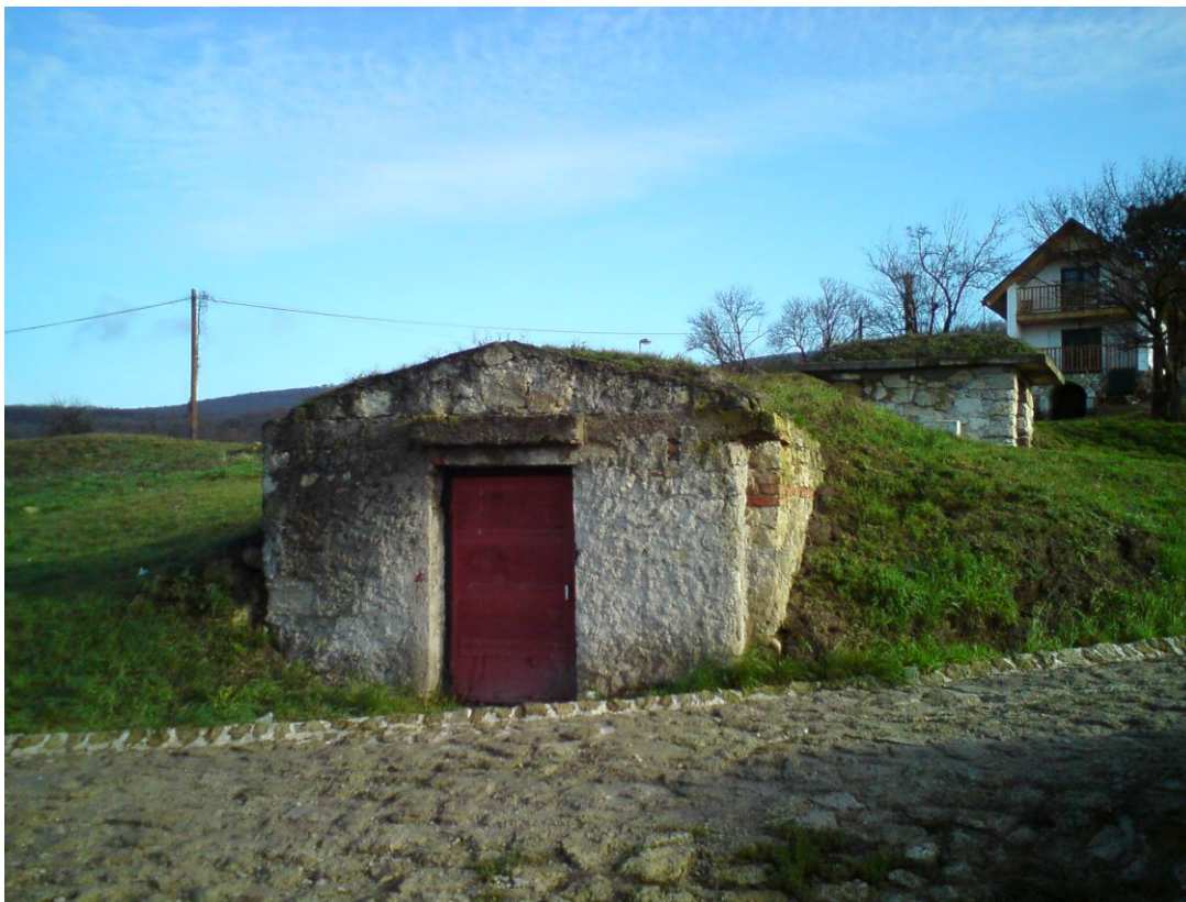
OBR. 56 PORTÁL PIVNICE Č. 4, V POZADÍ CHATKA NA PARC: Č. 146/3
