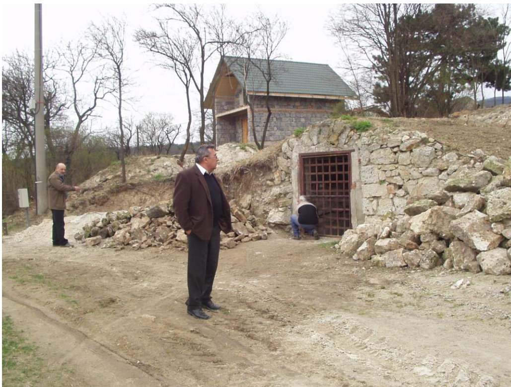
OBR. 23 PIVNICA Č. 9 (GRÓFA SÁNDORA SZECHÉNYHO), STAV PRED OBNOVOU V R. 2005
