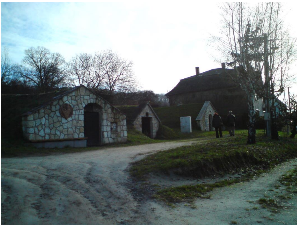
OBR. 14 POHĽAD NA RAD PORTÁLOV PIVNÍČ Č. 29, 30 A 31 (ZĽAVA DO PRAVA) V JUHOVÝCHODNEJ HORNEJ ČASTI PAMIATKOVEJ ZÓNY, VPOZADÍ JESTVUJÚCI STARŠÍ SOLITÉRNÝ RODINNÝ DOM
