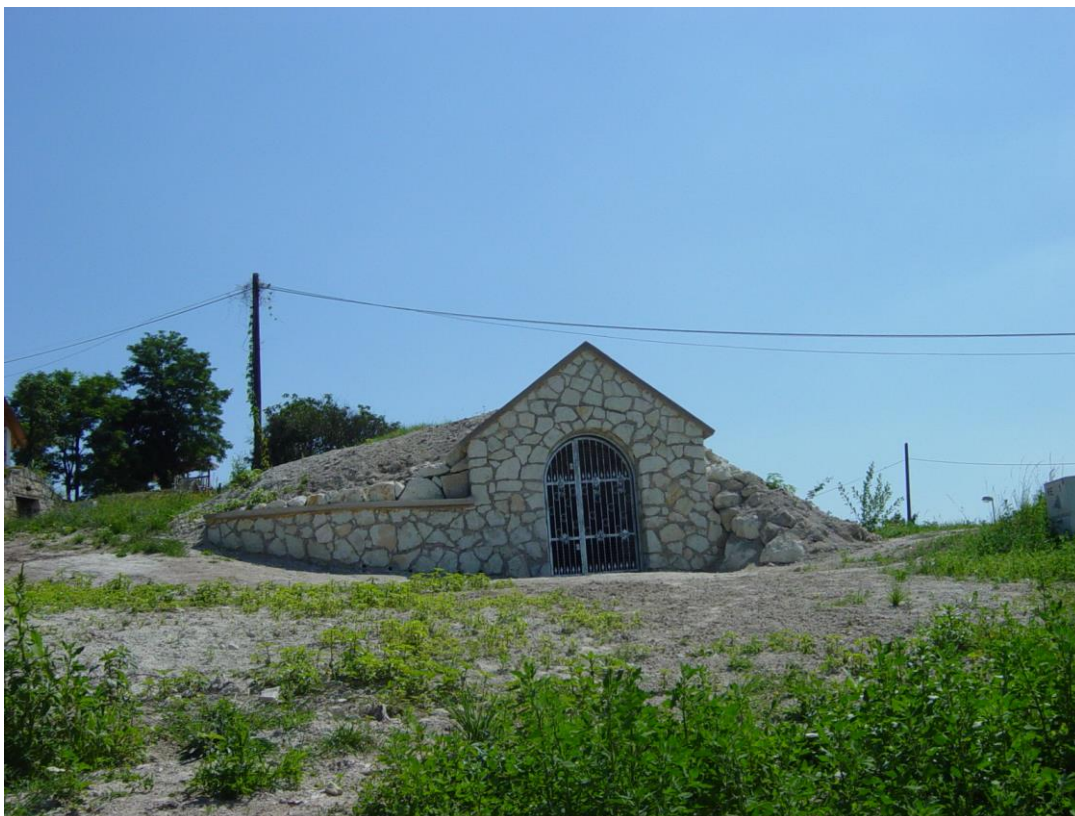
OBR. 53 PORTÁL PIVNICE Č. 6, PRÍKLAD NEVHODNEJ OBNOVY, NEREŠPEKTUJÚCEJ TRADÍCIU
