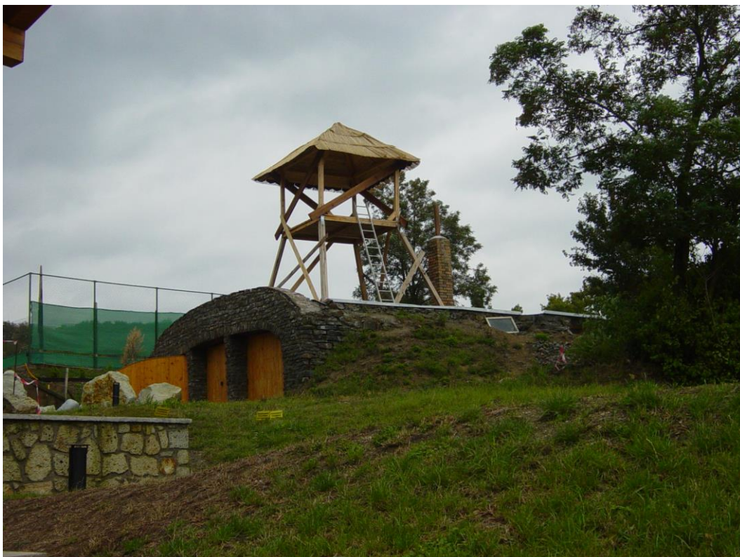
OBR. 21 POHLAD NA NOVODOBÝ OBJEKT GARÁŽÍ S DREVENOU VYHLIADKOVOU VEŽOU OPROTI RODINNÉMU DOMU NA PARC. Č. 149/1
