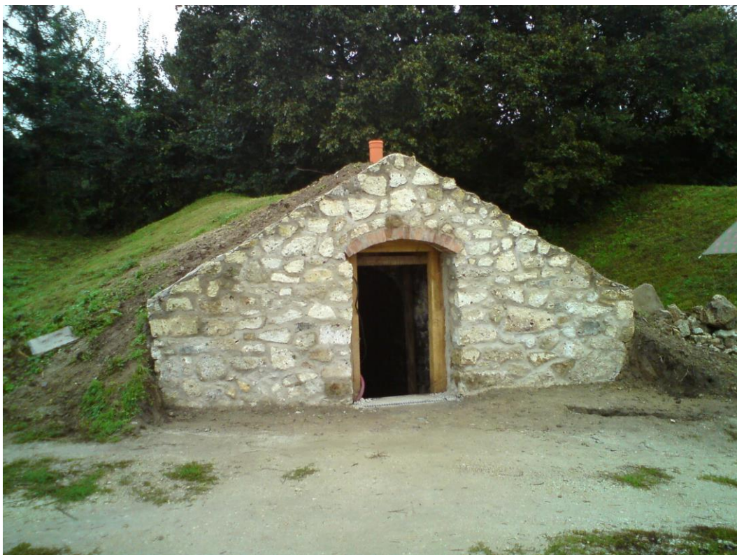
OBR. 35 PORTÁL PIVNICE Č. 27 PO OBNOVE PO PREBORENÍ VSTUPNÉHO ŽRIEDLA PO VÝDATNÝCH DAŽĎOCH V MÁJI 2010
