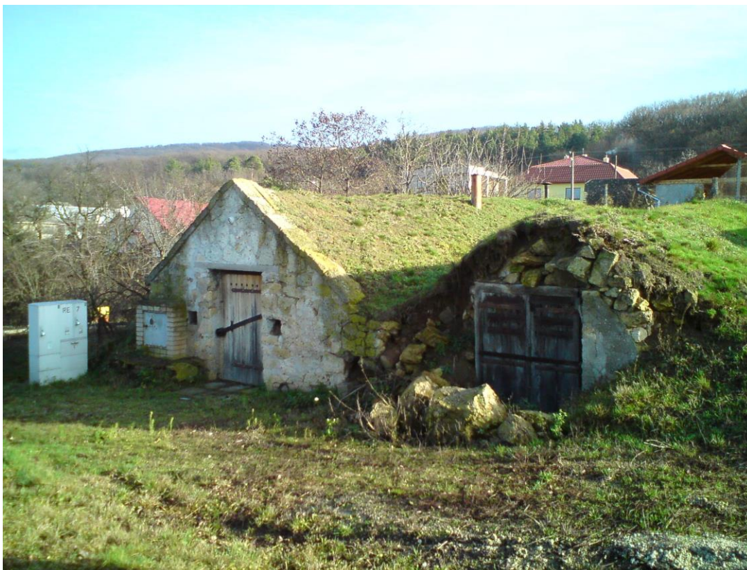
OBR. 43 PORTÁLY PIVNÍČ Č. 15 A 16 (ZĽAVA DO PRAVA), PORTÁL PIVNICE Č.16 OPUSTENÝ A ZBORENÝ
