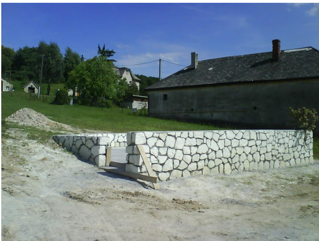
OBR. 16 POHĽAD NA KAMENNÉ MURIVO NOVODOBÉHO AMFITEÁTRA V JUHOZÁPADNEJ SPODNEJ ČASTI PAMIATKOVEJ ZÓNY, V POZADÍ DVA SOLITÉRNE STARŠIE RODINNÉ DOMY A PORTÁL PIVNÍC Č. 29, 30
