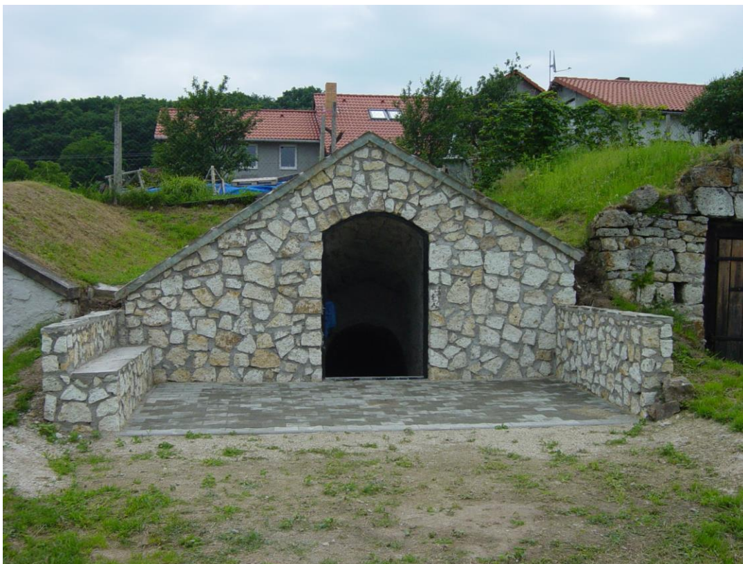
OBR. 45 PORTÁL PIVNICE Č. 18, PRÍKLAD NEVHODNEJ NOVODOBEJ ÚPRAVY PRIESTORU PRED PIVNICOU I PORTÁLU S NEVHODNÝMI PROPORCIAMI A KAMEŇOKLADOM
