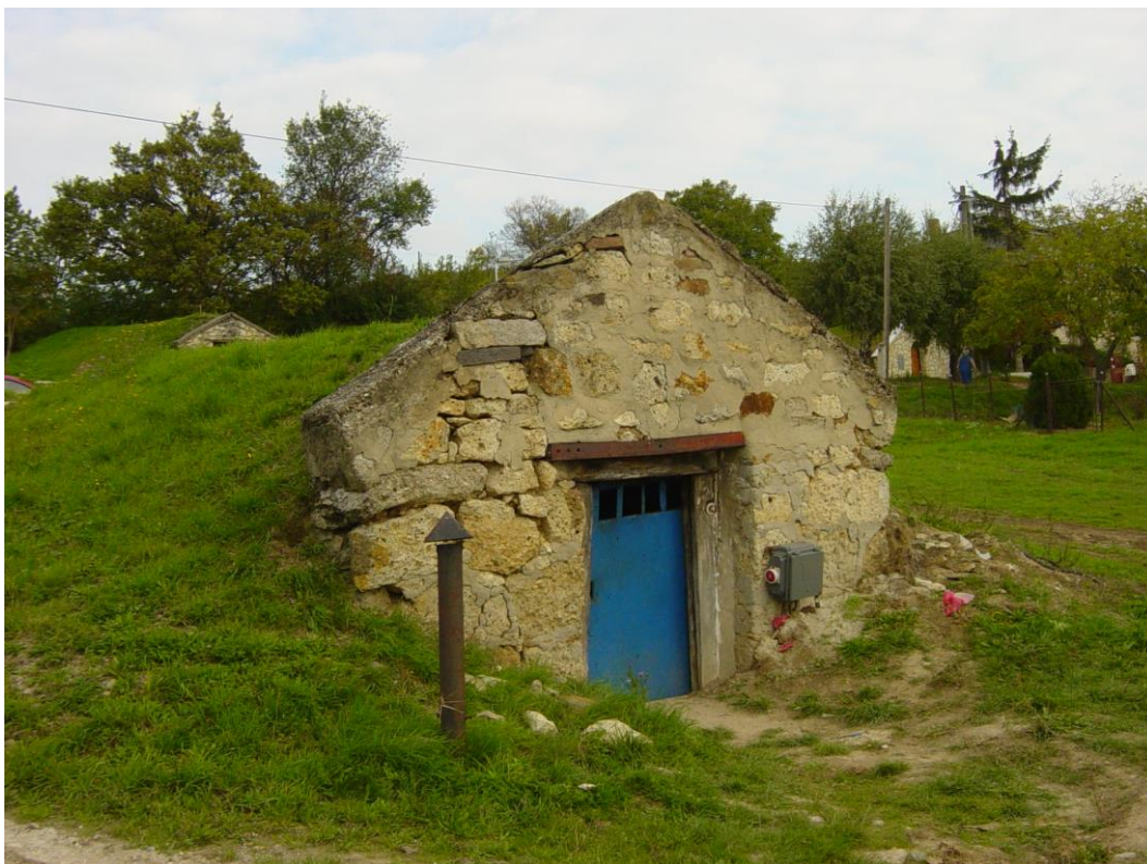
OBR. 61 PORTÁL PIVNICE Č. 1 PRED OBNOVOU, TRADIČNÝ TYP
