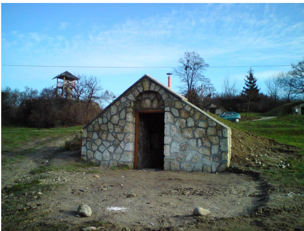
OBR. 60 PORTÁL PIVNICE Č. 1, PRÍKLAD NEVHODNEJ OBNOVY, NEREŠPEKTUJÚCEJ PREDCHÁDZAJÚCI STAV
