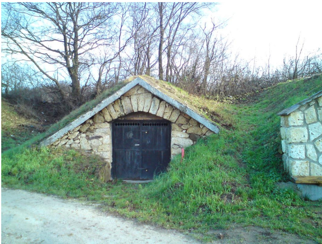
OBR. 33 PORTÁL PIVNICE Č. 28, VHODNÝ PRÍKLAD, REŠPEKTUJÚCI TRADÍCIU
