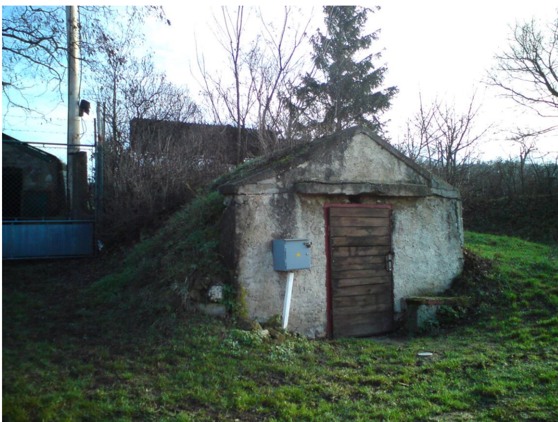
OBR. 38 PORTÁL PIVNICE Č. 26
