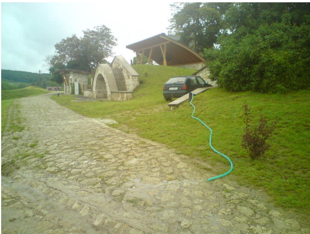
OBR. 22 PIVNICA Č. 9 (GRÓFA SÁNDORA SZECHÉNYHO) PO OBNOVE, POHLAD Z JUHU
