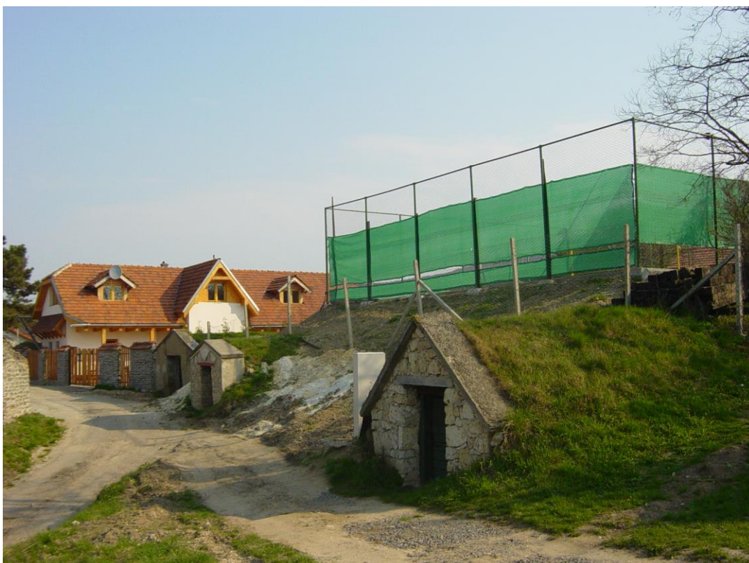
OBR. 18 POHĽAD NA PIVNICE Č. 23, 24 A 25 (ZĽAVA DO PRAVA), NAD NIMI RUŠIVÝ PRVOK OPLOTENIA TENISOVÉHO KURTU PRI RODINNOM DOME NA PARC. Č. 149/1 (V POZADÍ)
