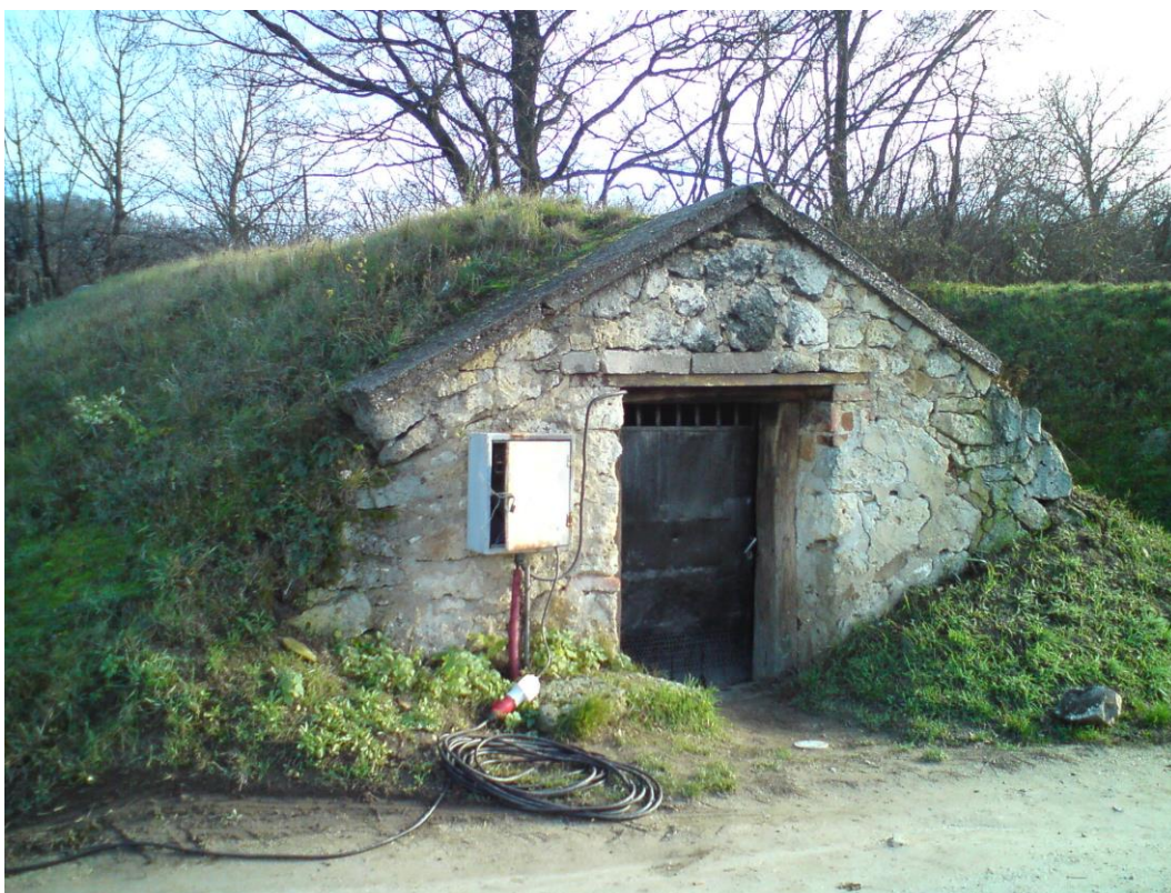
OBR. 34 PORTÁL PIVNICE Č. 27 PRED OBNOVOU
