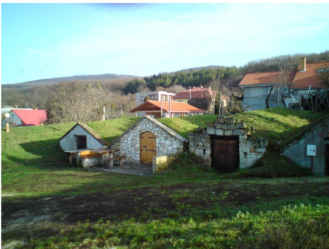
OBR. 44 PORTÁLY PIVNÍČ Č. 17, 18, 19 (ZĽAVA DO PRAVA), ÚPLNE VPRAVO ČASŤ PORTÁLU PIVNICE Č. 20
